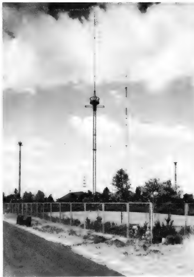
Bild 1. Blick auf das Stationsgelände von Wittsmoor vom Südosten. Im Vordergrund der 50-m-Mast mit verschiedenen UKW-Antennen. Rechts davon der 70- und der 28-m-Mast
