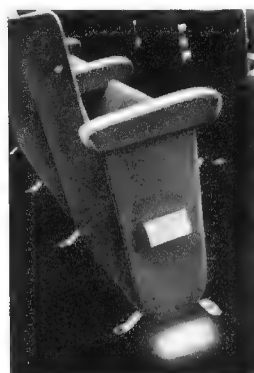
Bild 2. Philips-Lu-Leuchtplatte zur Kennzeichnung der Sitzreihen in einem Theater
